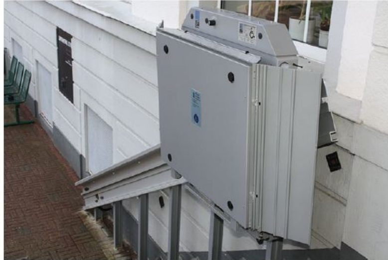
Schrägaufzug HIRO 350 im eingeklappten Zustand:
