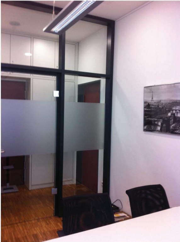
TRENNWAND AUS EINER PFOSTEN- RIEGELKONSTRUKTION
