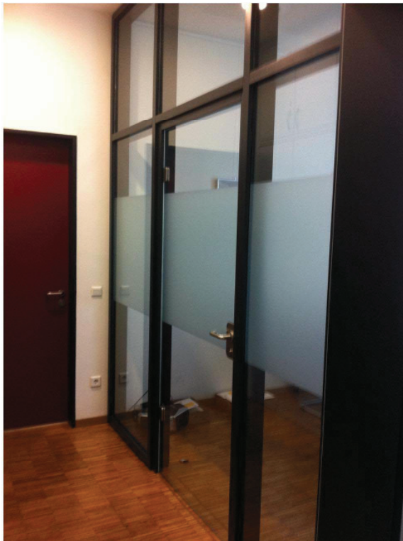
TRENNWAND AUS EINER PFOSTEN- RIEGELKONSTRUKTION
