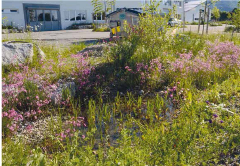
Anlage von Retentionsmulden
