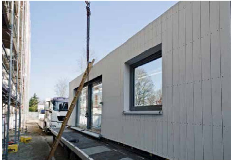
Energieeffizienz durch Abwärmenutzung und moderne Dämmstandards
