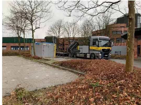
Abbau der Containerbüros
