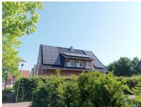
Abbildung 3-6: Eine Photovoltaikanlage. (Quelle: Gemeinde Ostbevern)
