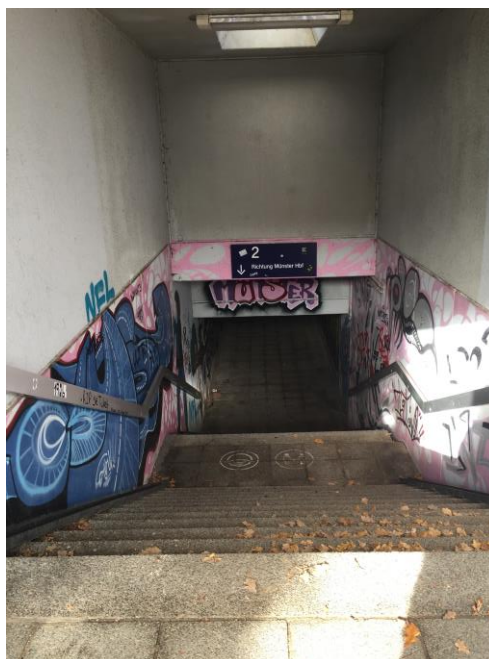
Unterführung Bahnhof Ostbevern
