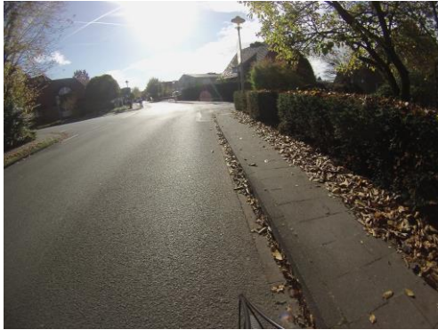
Engelstraße/ Liener Damm (Fahrbahn bei 50 km)
