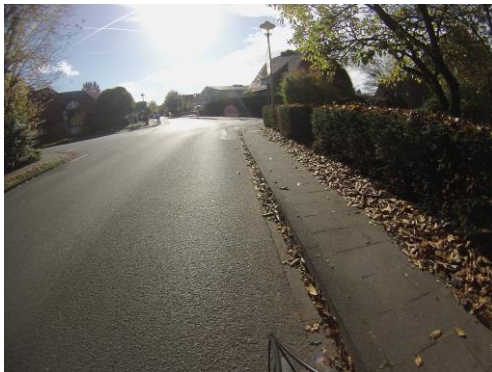
Engelstraße/ Liener Damm (Fahrbahn bei 50 km)
