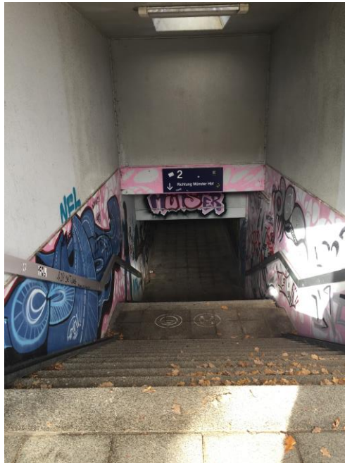
Unterführung Bahnhof Ostbevern
